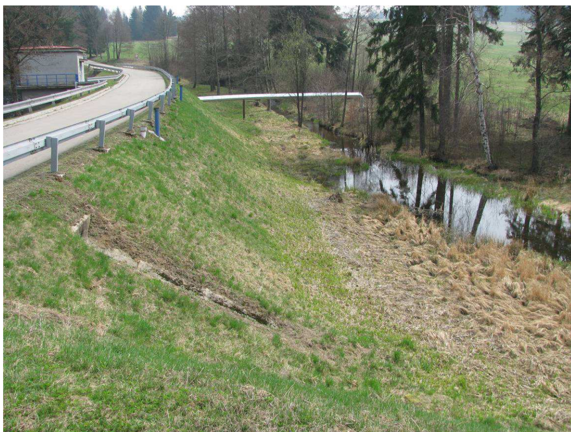
Obr. 6 Pohled na vzdušný svah hráze s objektem vodárenského zařízení a výtlačným potrubím na úpravnu vod v popření vyústění odvodnění vozovky na koruně hráze
