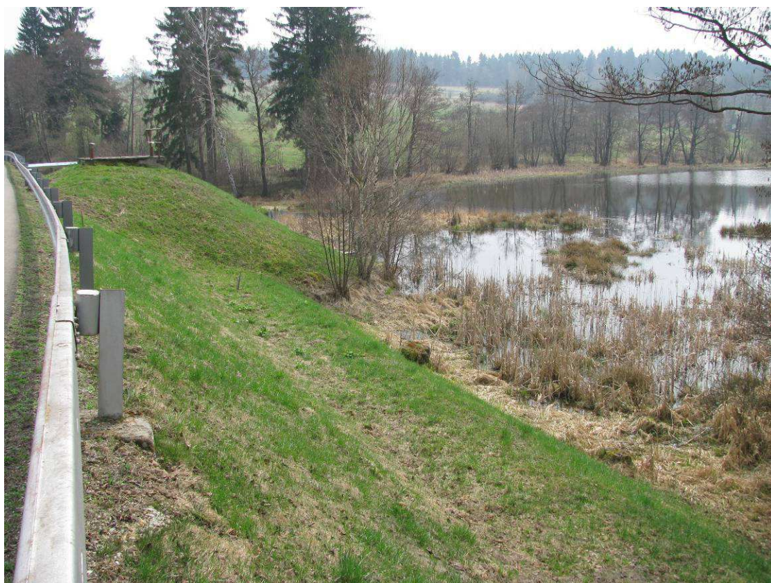
Obr. 5 Pohled na vzdušný svah hráze v místě rozšíření u výpustního objektu do rybníka Pilný
