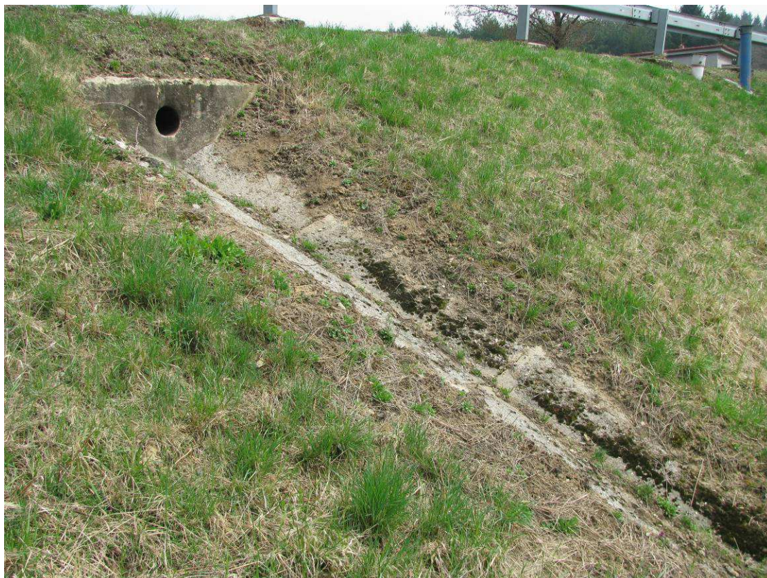
Obr. 7 Detail vyústění odvodnění koruny hráze
