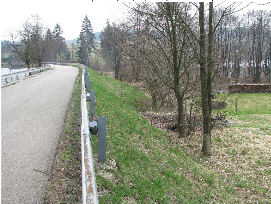
Obr. 2 Pohled na vzdušný svah hráze v místě začátku plánované gabiónové stěny se stromy a keři k odstranění
