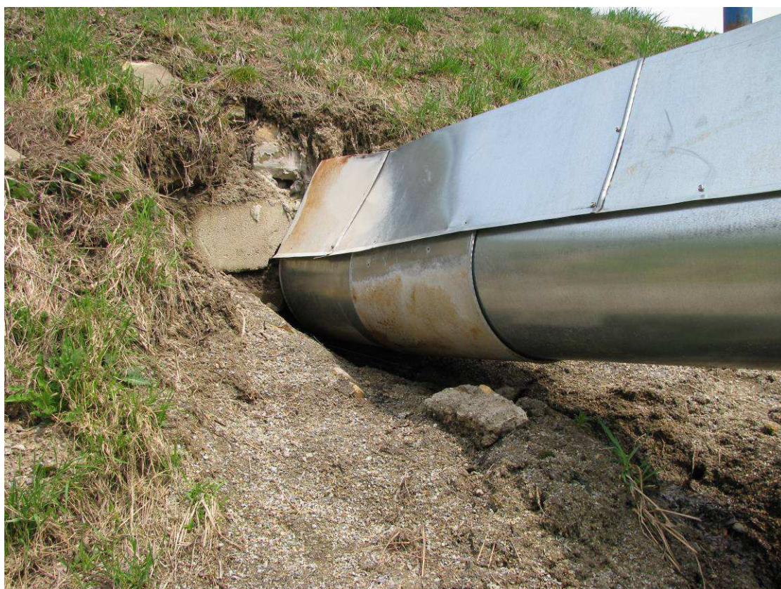
Obr. 8 Detail vyústění výtlačného potrubí na úpravnu vod s opláštěním
