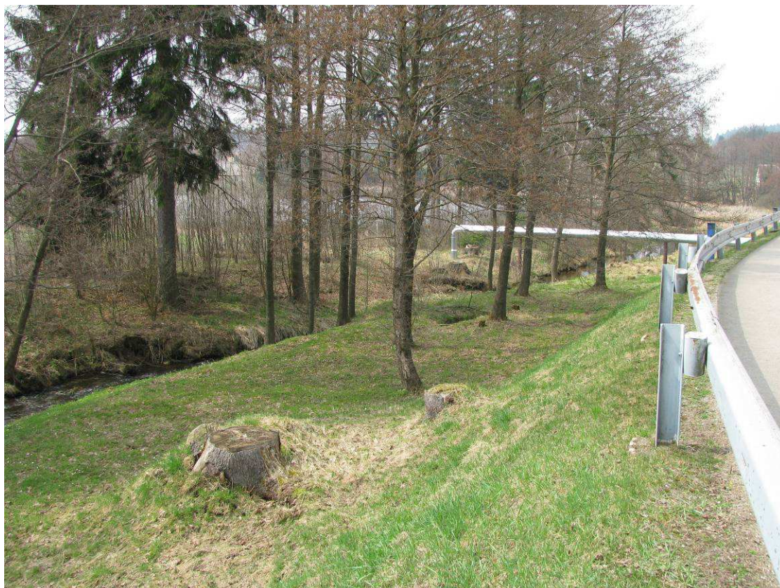
Obr. 9 Pohled na vzdušný svah hráze v místě zavázání do levého břehu se stromy a pařezy navrženými k odstranění
