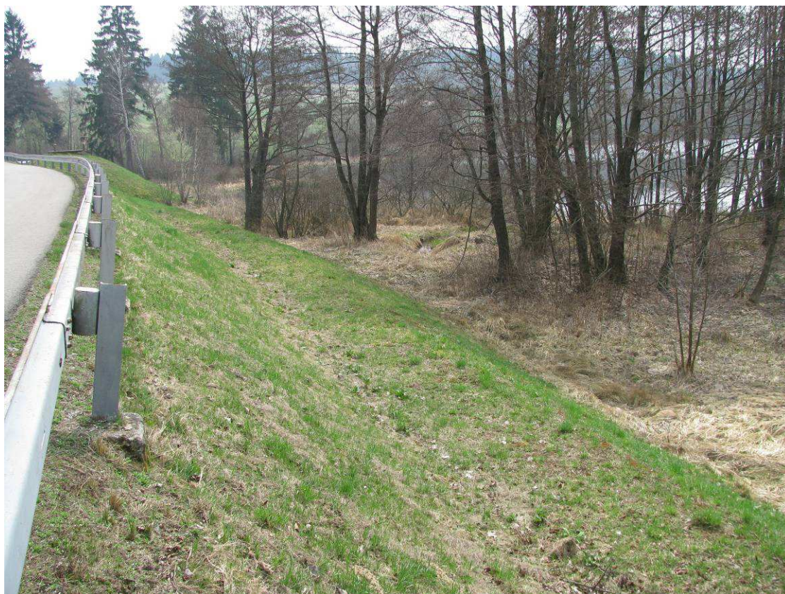
Obr. 4 Pohled na vzdušný svah hráze v místě v minulosti provedené přitěžovací lavice
